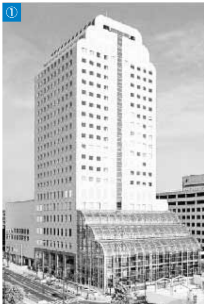
当財団が活動の拠点とする 千里ライフサイエンスセンタービル
